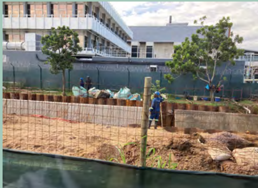
写真7 eThekwin市トヨタ南アフリカ工場前の排水路工事、2022年水害で工場も浸水
