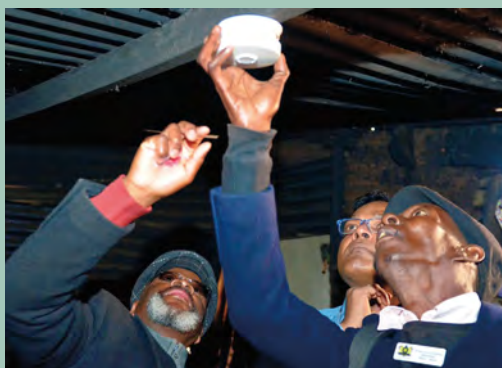
写真11 バラック内に火災警報器を設置
