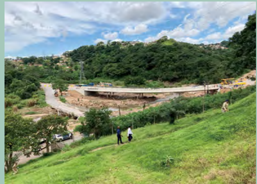
写真8 2022年水害で流出した橋(左)の付替え工事(右)
