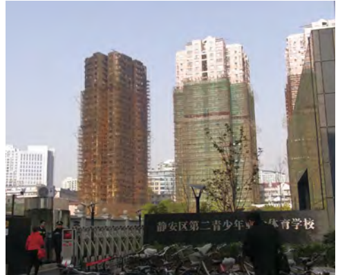
写真1 上海市の高層集合住宅火災で焼損した建物（一番左の棟） ※筆者が2010年12月に現地で撮影
