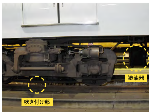
写真7 塗油器及び吹き付け部の状況
