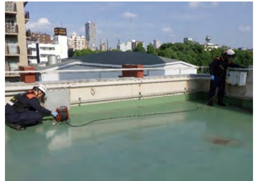
写真7 低圧用プルボックスと高圧ケーブル保護管の導通確認状況③
