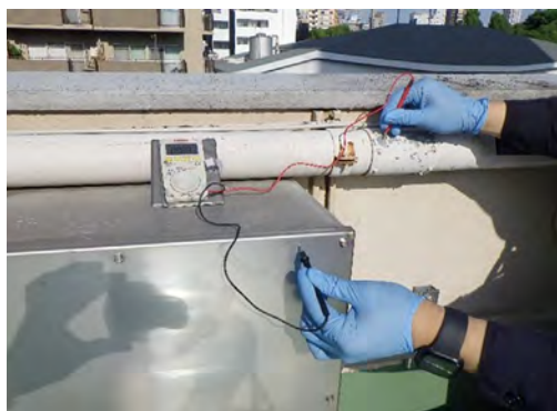
写真5 低圧用プルボックスと高圧ケーブル保護管の導通確認状況①
