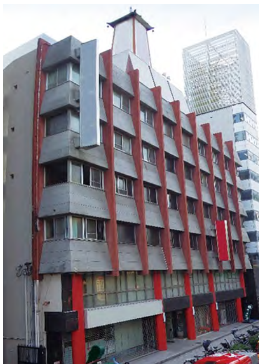
写真1 発災建物外観
