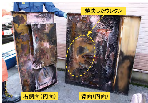
焼損したコンプレッサ内部の状況
