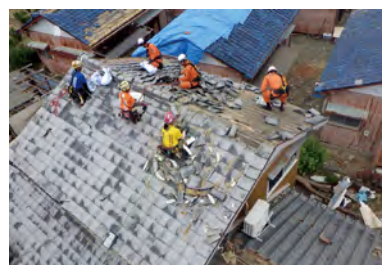
消防機関による高所作業の様子（静岡県消防局提供）
