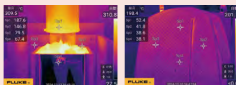
サウナ室内の温度状況
