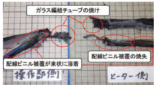
写真6 電気配線の状況
