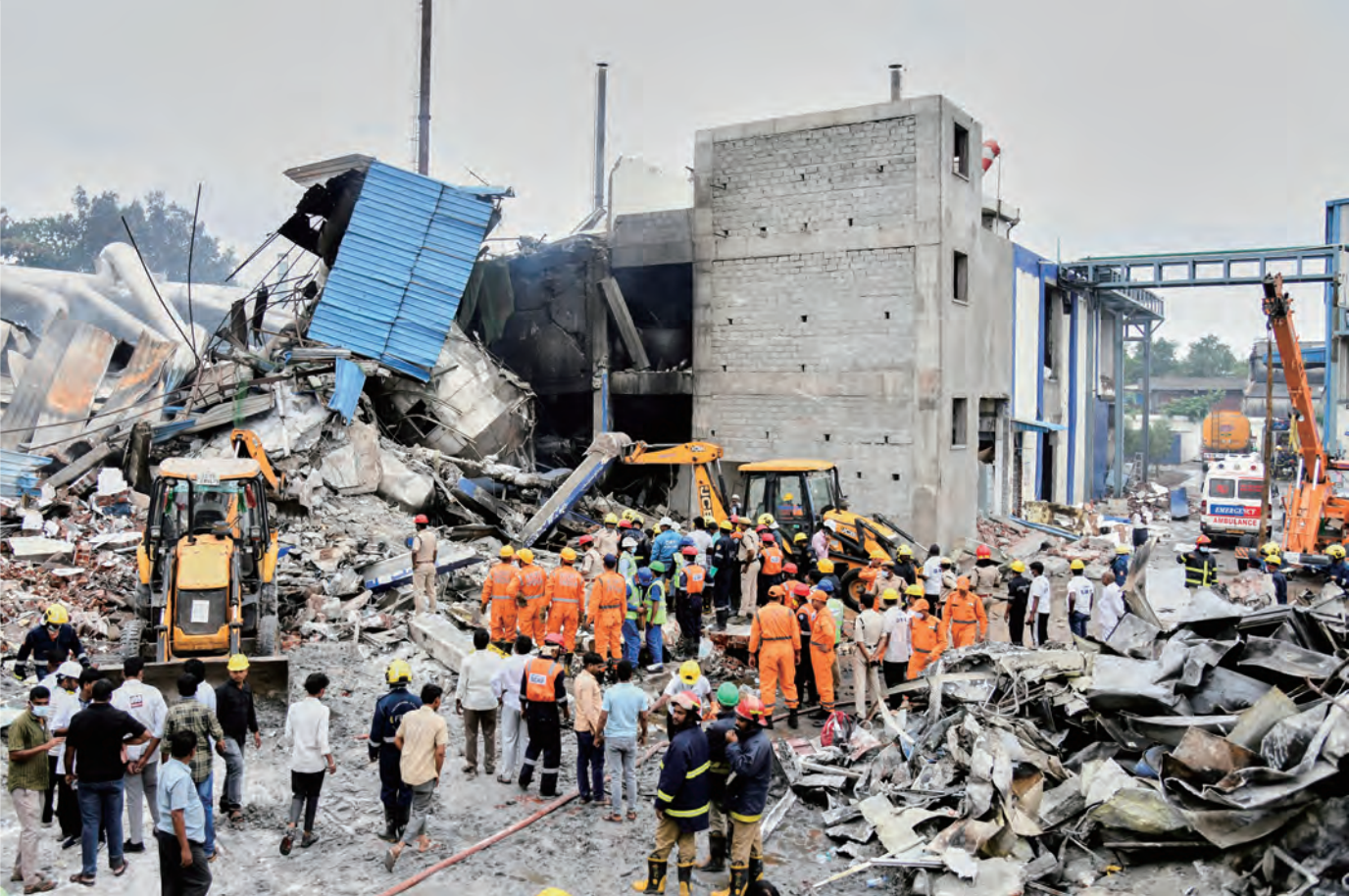
インド・テランガーナ州で発生した工場火災(2025年6月30日)(写真:AP/アフロ)
