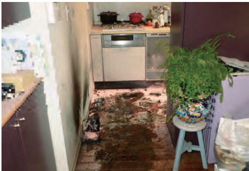
写真3 台所付近の状況
