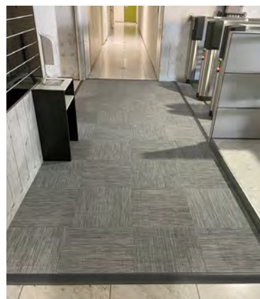
図5 火勢抑制フロア設置例(上：ベース材のみ、下：仕上材)
