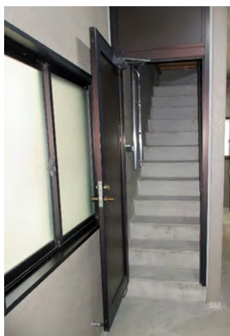
4階共用部の状況
