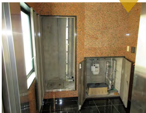
5階EV前共用部の状況
