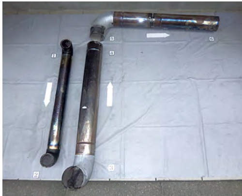
取り外した縦ダクトとつなぎダクト
