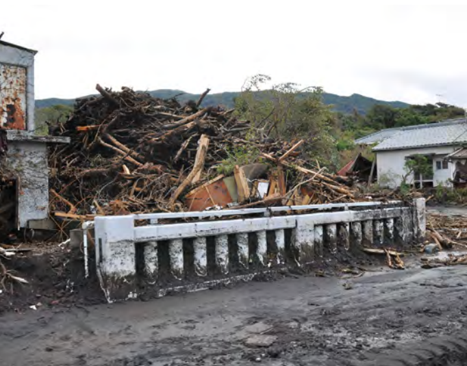
写真3 2013年台風26号による伊豆大島での土砂災害は島中心地の元町を襲った
