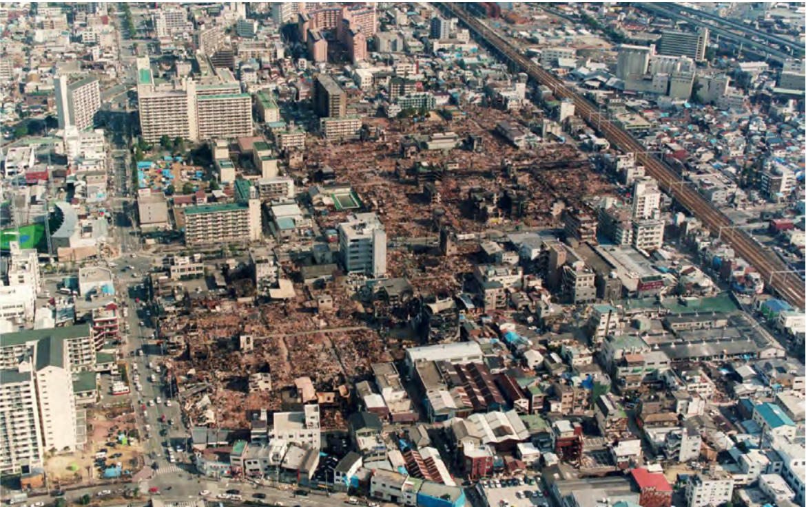
写真3 阪神・淡路大震災時の大規模延焼地区(菅原市場周辺)の延焼範囲とその焼け止まり状況(写真:神戸市)
