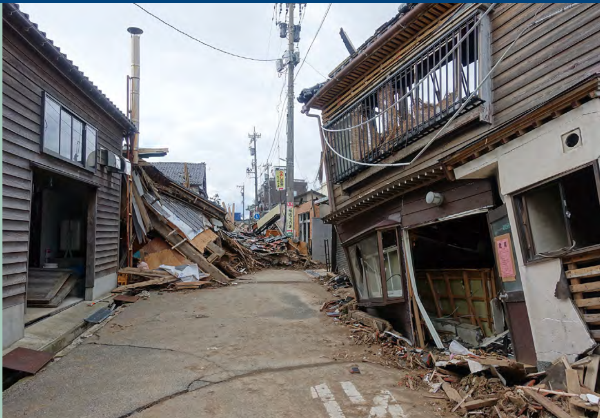
能登半島地震 輪島市の被害状況(出典:令和6年能登半島地震アーカイブ(提供者:石川県/CC BY-NC-SA-4.0))
