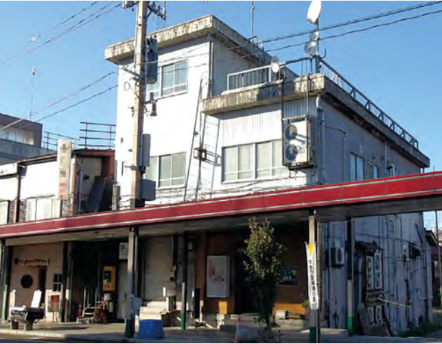
違反防火対象物外観
