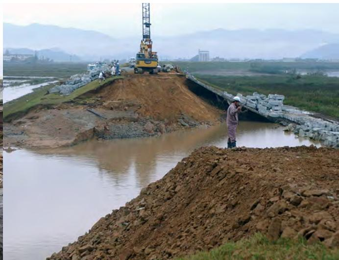
写真4 2004年台風23号による円山川の堤防決壊現場 (撮影・時事通信社)
