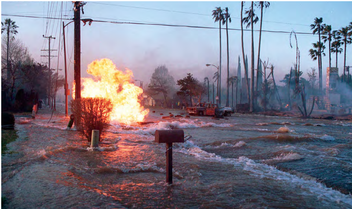
写真2 ノースリッジ地震における地中ガス配管損傷による火災(写真: AP/アフロ)
