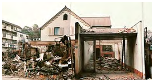
写真5 兵庫県南部地震の火災で延焼を免れた住宅 1)
