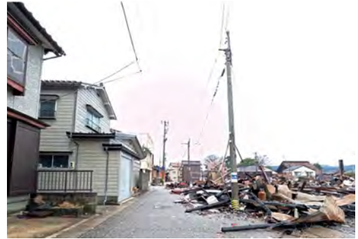
写真8 伊右エ門小路の焼け止まり 2)
