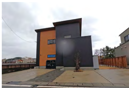
写真4 北端で延焼を免れた住宅(西側の住宅) 2)
