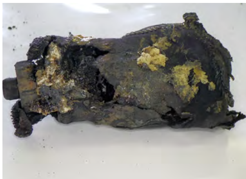
写真2 焼損したバッテリーの状況
