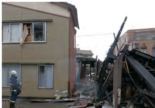
写真2 南端の狭い建物間の焼け止まり 2)
