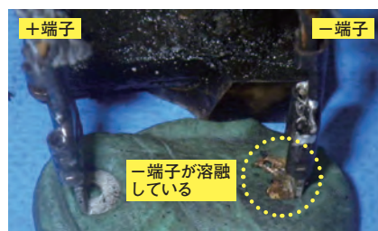
写真10 焼損品ダイオード内部
