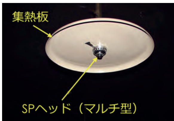
図1 集熱板の外観（一般に直径40cm程度の円板状のものが使用されている。）
