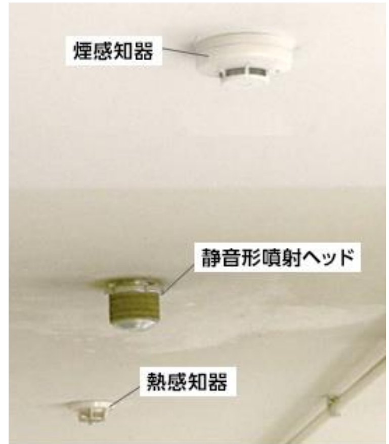
静音形噴射ヘッド取付例
