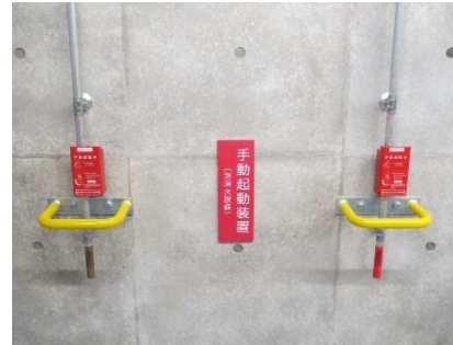
手動起動装置に保護ガードを設置
