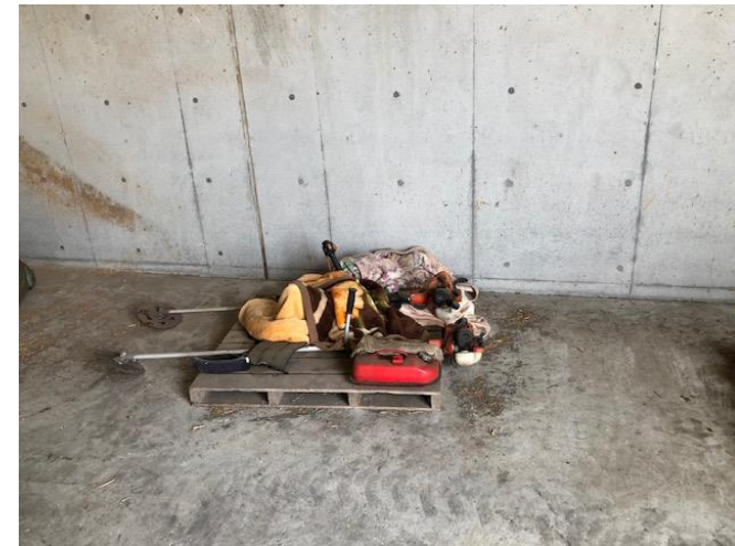
②機材用燃料の保管状況
