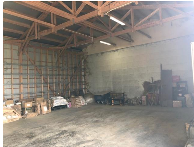
④倉庫内の様子
