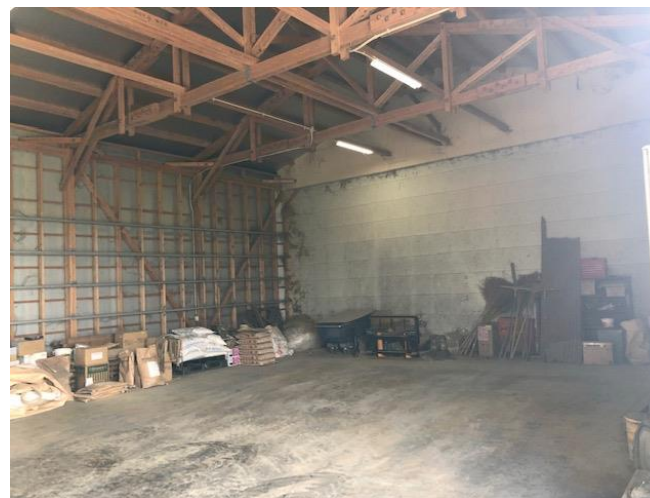
④倉庫内の様子
