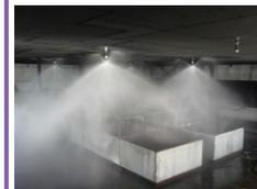
高圧の水を噴霧状に放出することで、駐車場における火災拡大を抑制する設備
