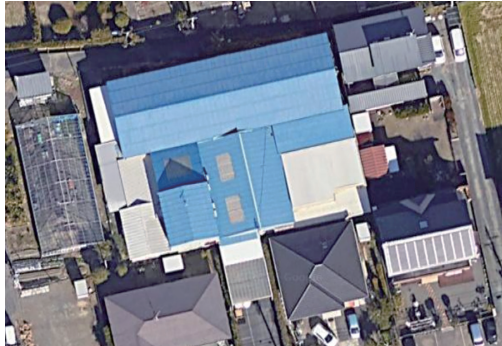
航空写真(青白屋根が当該工場・周辺は一般住宅)(出典: Google Earth)
