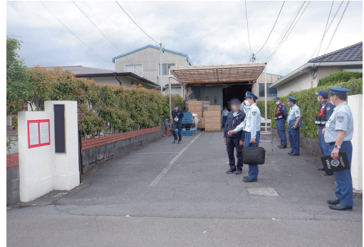
建物外観と標識
