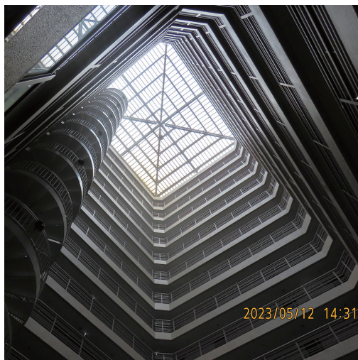
ガラス屋根の状況
