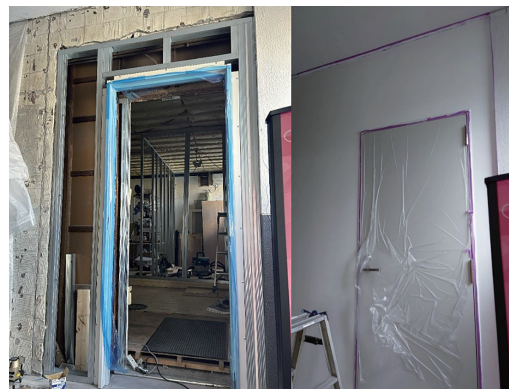
Bビルの堅穴区画改修状況
