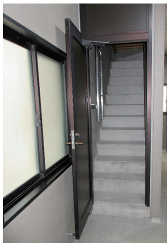
4階共用部の状況
