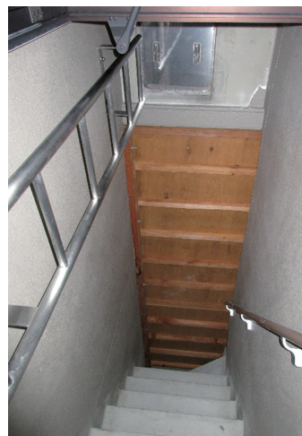
固定はしごと閉鎖箇所の状況
