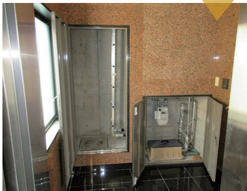
5階EV前共用部の状況
