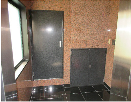
5階EV前共用部 工事前
