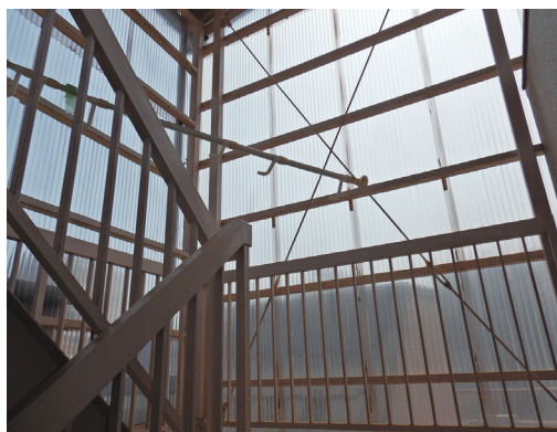
階段部分を覆う樹脂製波板
