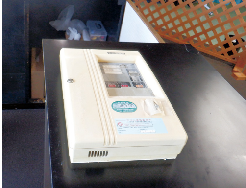
取り外された自動火災報知設備の受信機
