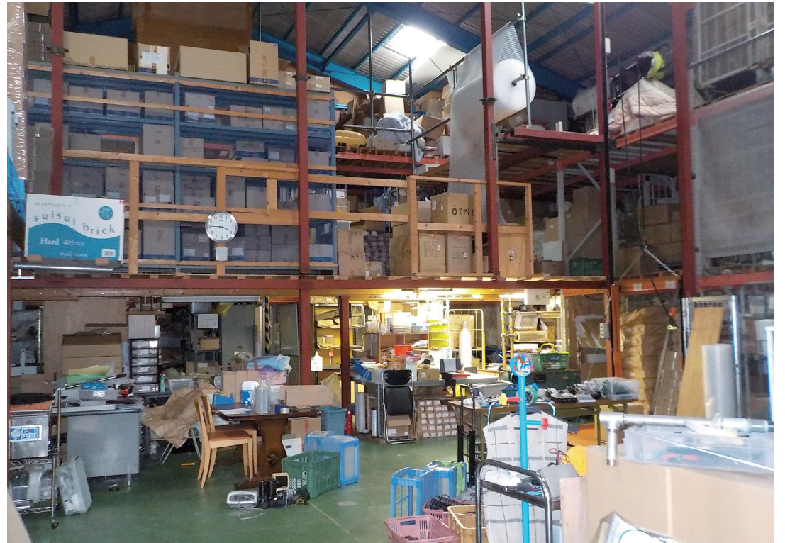
建物内部における増築の状況
