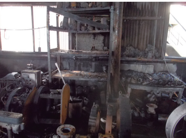
是正完了後の状況
