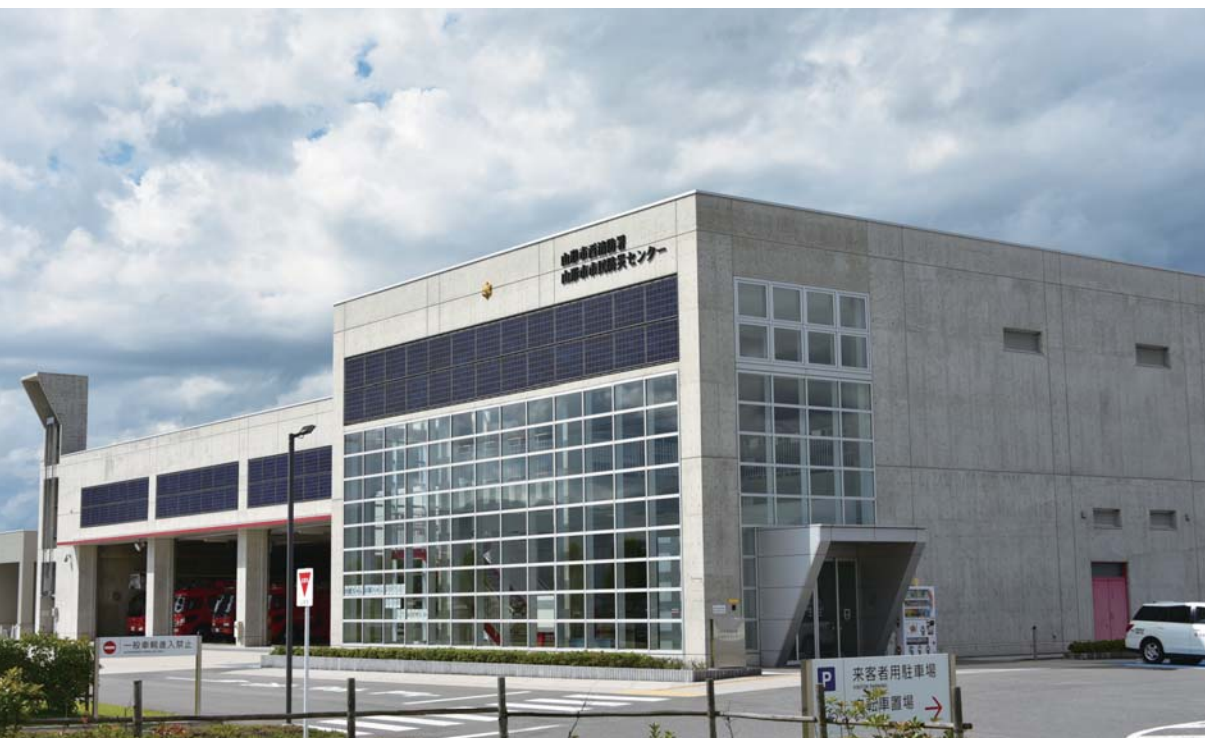
体験型の山形市民防災センターを併設する山形市西消防署
