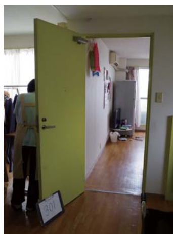
居室出入口扉の状況
