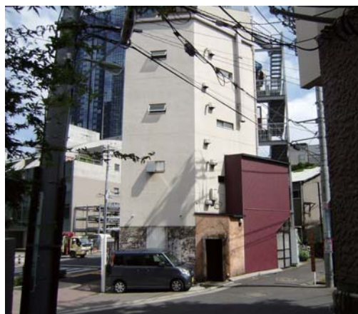
防火対象物側面の屋内階段増設部分
