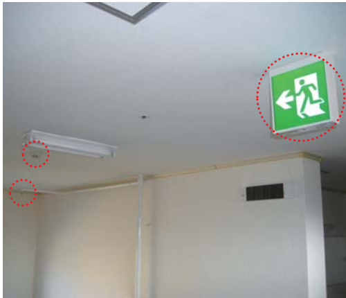
スプリンクラーヘッド・感知器・誘導灯の改修状況
