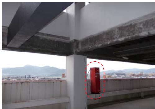
減築工事後の駐車場の状況(3階) 3階の一部天井とともに泡消火設備がなくなったため、本市運用に基づき移動式粉末消火設備により包含することとした。
