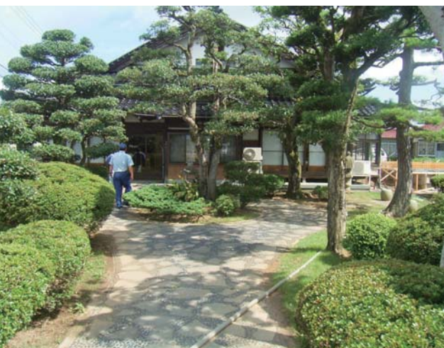
防火対象物の外観
