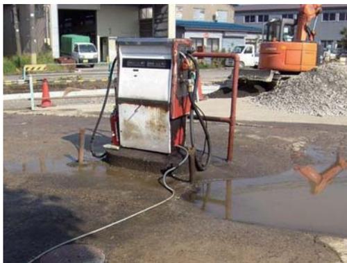
無許可で電気配線を敷設し、技術基準にも適合していないなどの違反事実(平成22年7月実況見分時)
