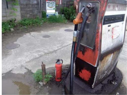
点検の未実施、消火器不適合、地盤面の舗装、敷地外への流出防止措置なし、などの違反事実を再度確認(平成21年7月実況見分時)
