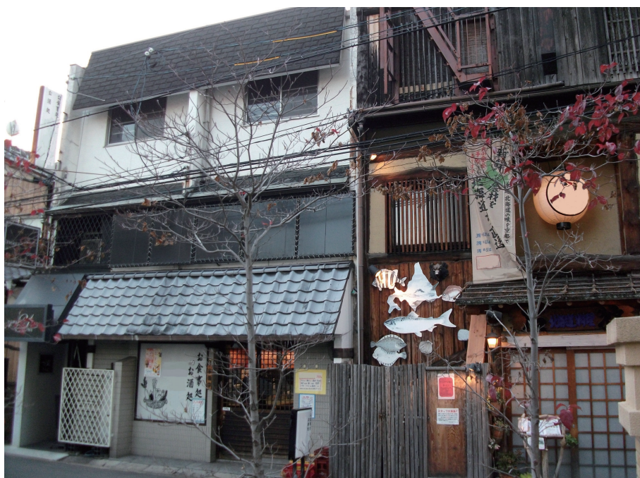
本対象物外観を東側から撮影
