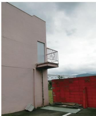
写真3 切断された2階屋外階段
