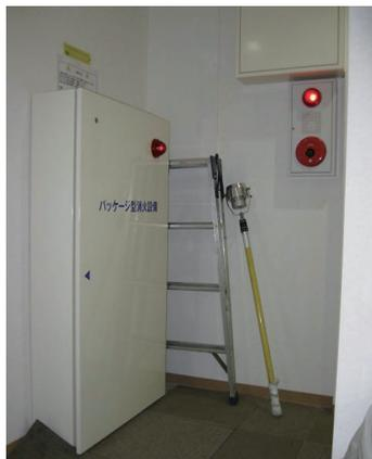
2階に設置したパッケージ型消火設備及び自火報受信機
