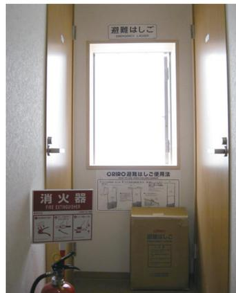
2階廊下西端の壁体に開口部と避難器具を設置
