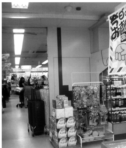
平成22年7月20日立入検査の状況 防火扉の周辺に商品存置あり(防火戸の閉鎖障害)。
