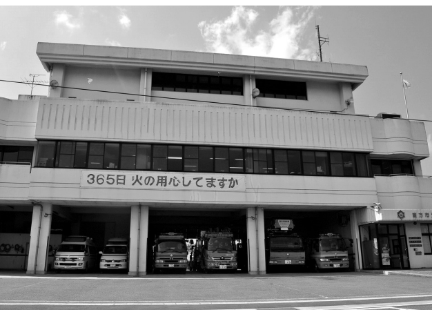
消防本部庁舎
