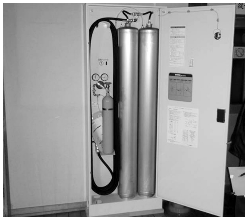
パッケージ型消火設備の検査
