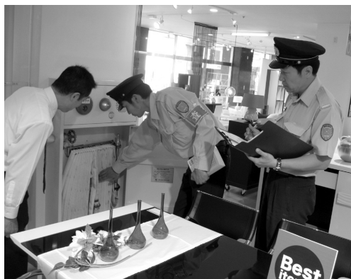
消火設備設置
