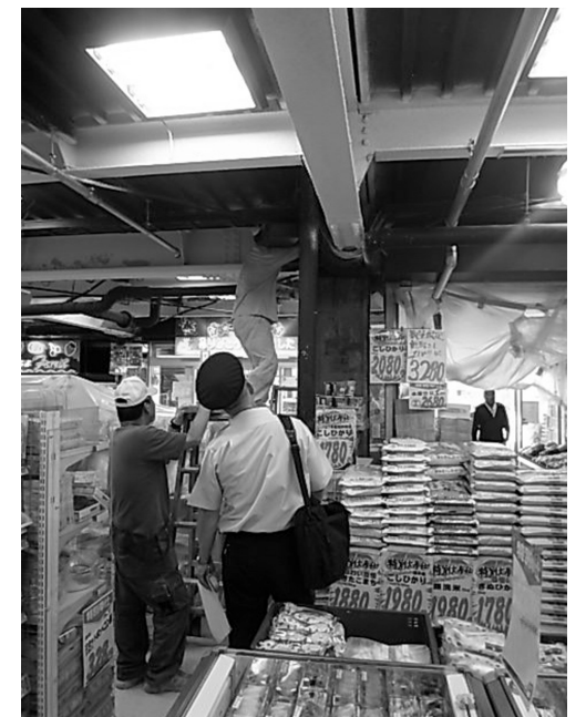
上：営業中のスプリンクラー設備設置工事の状況 左：1階店舗内の状況(スプリンクラー配管がみえる。)
