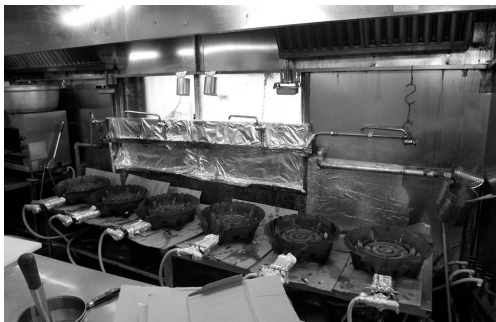
店舗バックヤードの状況①(食品加工のための厨房がある。)
