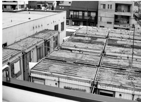
建物南側から見た屋上部分
