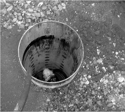
写真5 油回収井戸の状況
