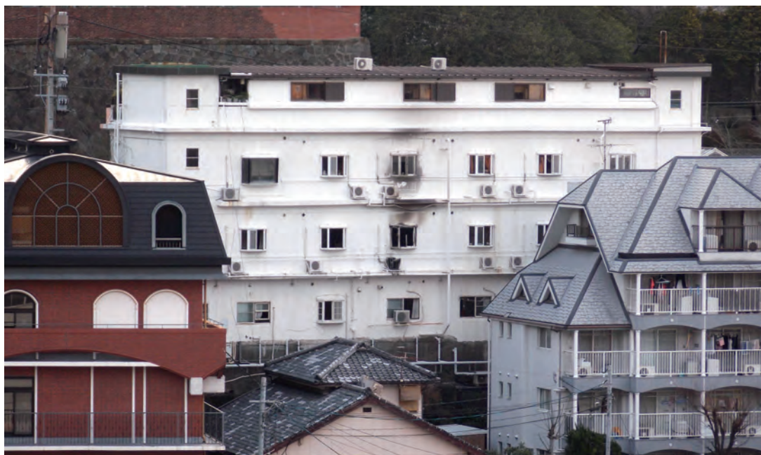
長崎市認知症グループホーム火災の建物外観
