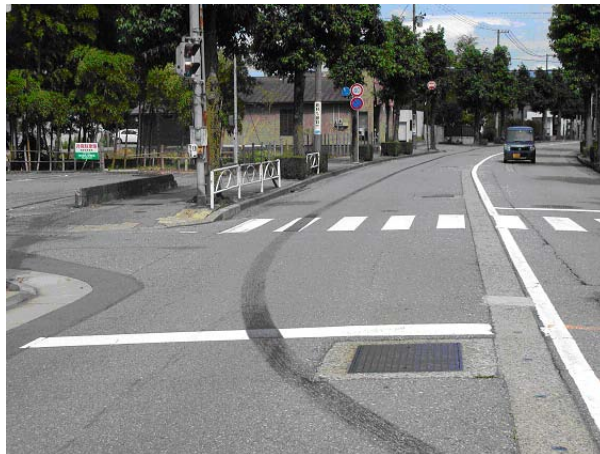
路面の状況（路面にタイヤ痕が確認できる。）
