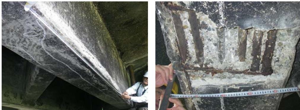
図1 塩害（融雪材）のよって損傷を受けた構造物
