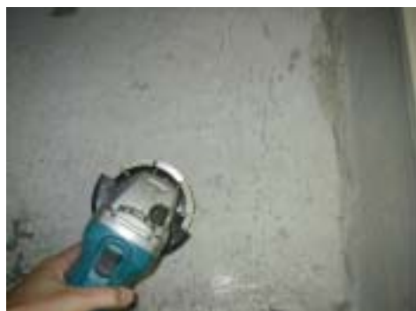
写真ー1 ディスクサンダーによる表面平滑化の例
