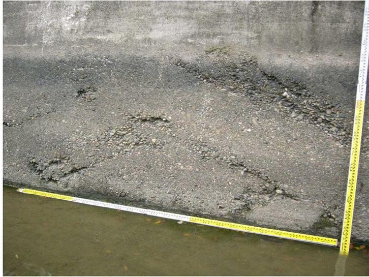
図-4.5 施工時の締固め不足による豆板の事例
