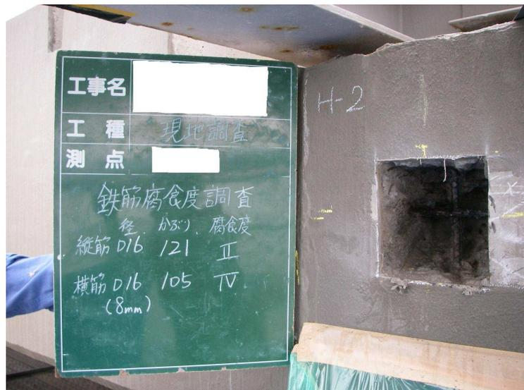
図-4.15 鉄筋の腐食度調査事例(1)
