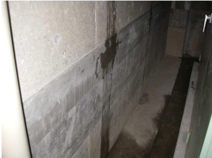
図-4.6 打継部の補修跡の事例
