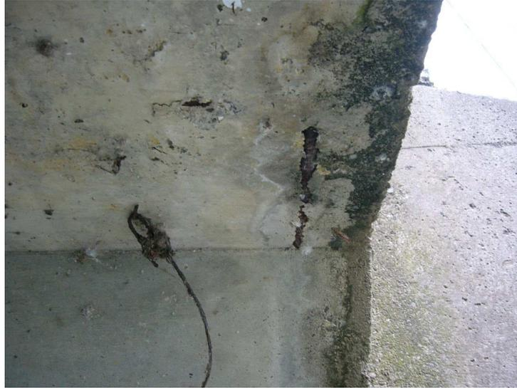
図-4.3 かぶり不足による鉄筋露出の事例
