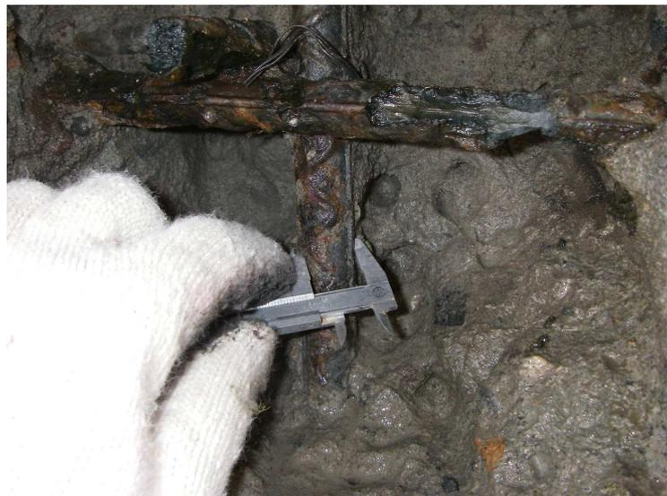
図-4.16 鉄筋の腐食度調査事例(2)
