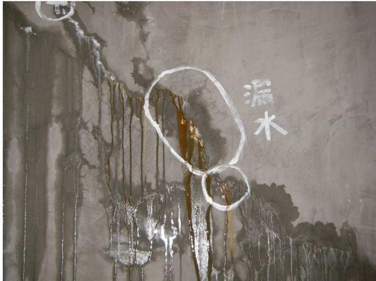
図-4.1 漏水を伴うひび割れの事例
