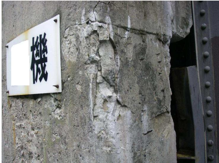
図-4.4 浮き・剥落の事例
