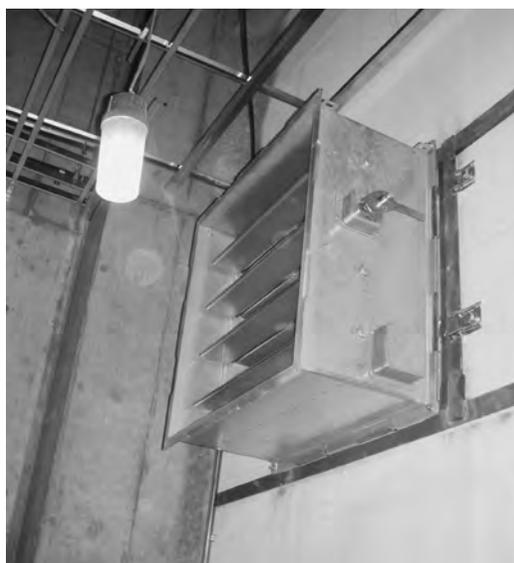
写真4 拠点に設置された差圧ダンパー（施工中）
