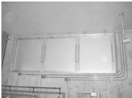
写真5 火災室上部に設置された排煙口（施工中）
