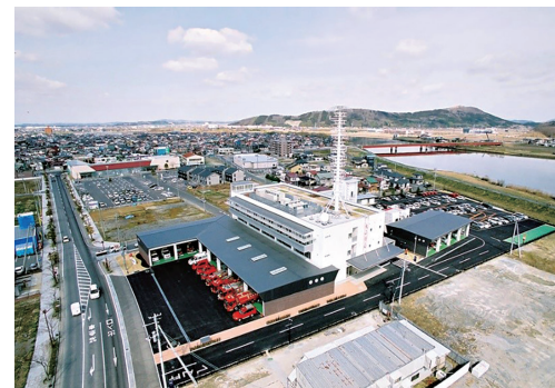
消防本部庁舎
