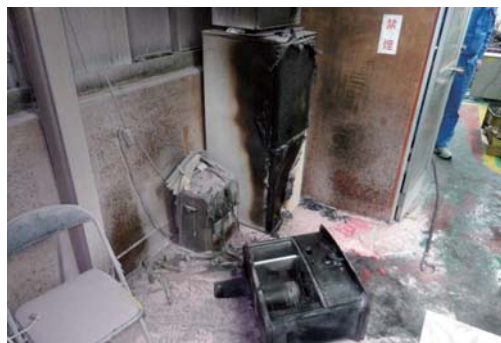
昨年度、特例によるパッケージ型消火設備の設置により是正された物件。今年1月に火災が発生し、その設備により初期消火が成功した。特例での設置という小さな諦めが、功を奏した。
