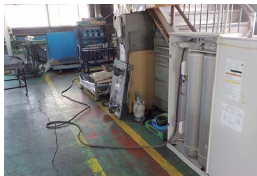
昨年度、特例によるパッケージ型消火設備の設置により是正された物件。今年1月に火災が発生し、その設備により初期消火が成功した。特例での設置という小さな諦めが、功を奏した。
